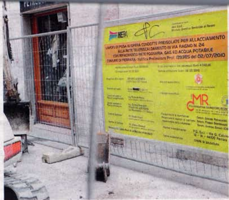
Uno dei cantieri della Cmr per la manutenzione ed il ripristino della rete idrica nel centro storico di Ferrara
